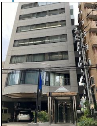
「北四番丁ステーションビル」外観
